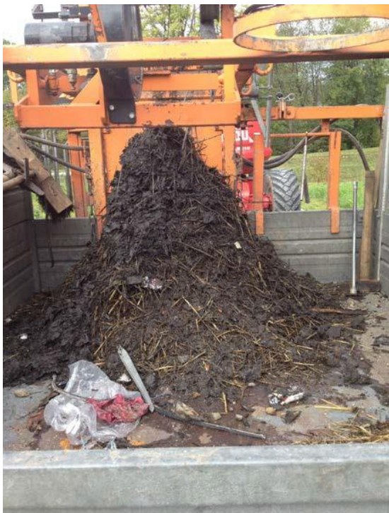
Abbildung 4: Kehrgut_aus_Entwässerungsschlitzrinne_Tunnel_Ettendorf
