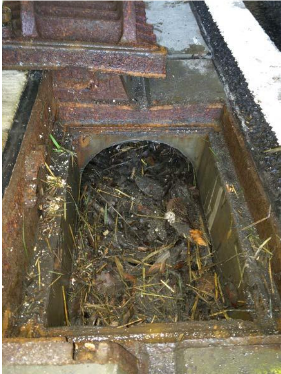
Abbildung 3: Tunnel_Ettendorf_verschmutzte_Schlitzrinne
